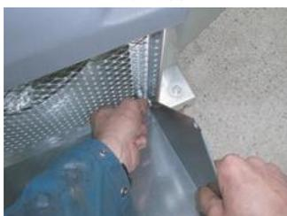
**2** - Fixation du déflecteur en partie haute par les vis **nylon** fournies
